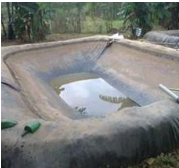
Étang creusé avec revêtement
