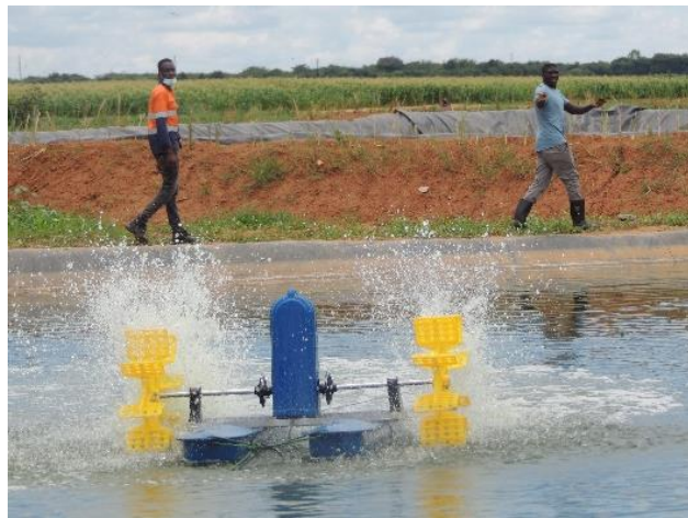
Un aérateur d'étang à poissons installé par un groupe de jeunes Agripreneur
